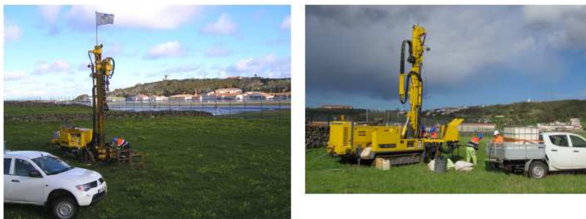
Fig. A1.2 - Aspecto das condições dos locais onde se realizaram as sondagens S3A e S3B
