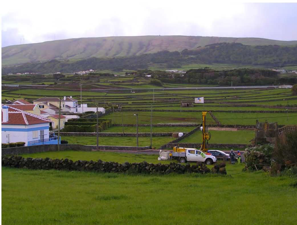
Figura 32 – Realização da sondagem S7B.
