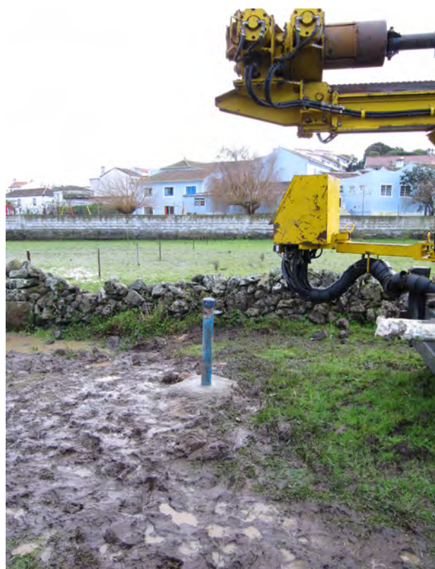
Figura 28 – Aspecto das condições dos locais onde se realizaram as sondagens S5A e S5B.
