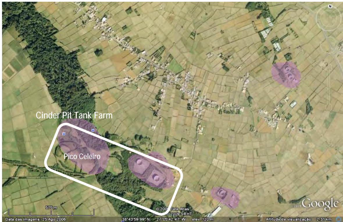
Figura 2 – Localização de depósitos subterrâneos e superficiais junto ao Pico Celeiro, do Cinder Pit Tank Farm, no qual se armazenava o combustível que alimentava o pipeline com o mesmo nome.
