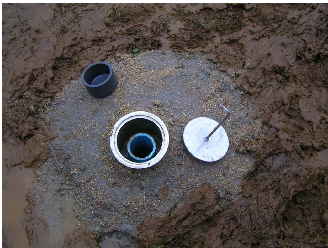
Figura 34 – Aspecto do sistema de tamponamento do piezómetro instalado na sondagem S8.
