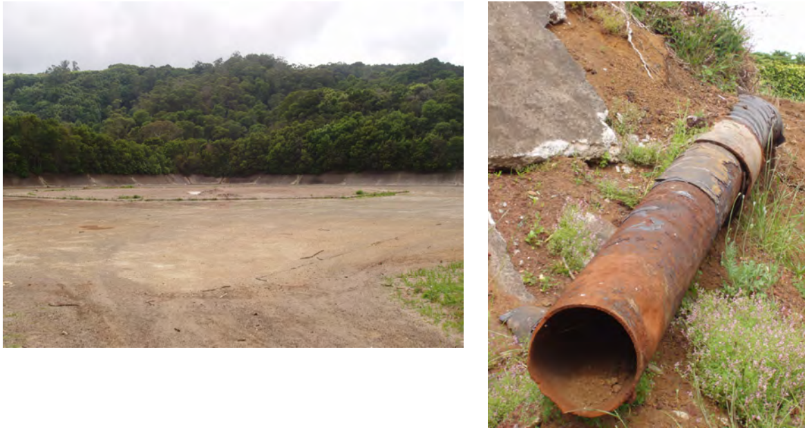
Figura 4 – Bacia de retenção de um dos depósitos superficiais já desmantelado e aspecto do ramal do pipeline que ligava ao antigo depósito em Pico Celeiro.
