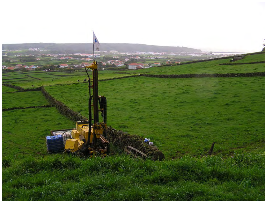
Figura 33 – Realização da sondagem S8.
