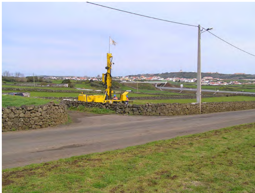
Figura 23 – Aspecto das condições dos locais onde se realizaram as sondagens S2A e S2B.
