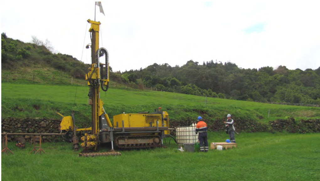
Figura 26 – Aspecto das condições do local onde se realizou a sondagem S4.
