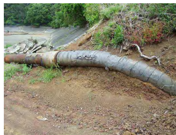
Fig. 62 – Pormenor do pipeline na Cova das Cinzas
