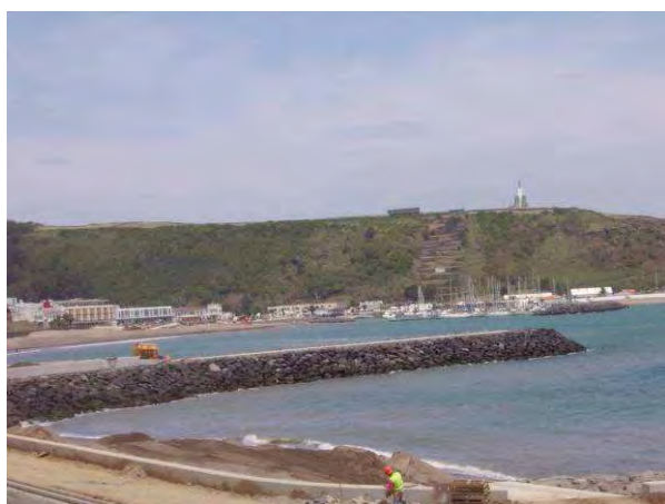
Fig. 21 – Escarpa de falha de Santiago e areias de praia (Praia da Vitória)
