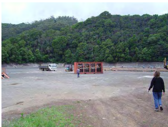
Fig. 59 – Vista geral da área da Cova das Cinzas e trabalhos em curso
